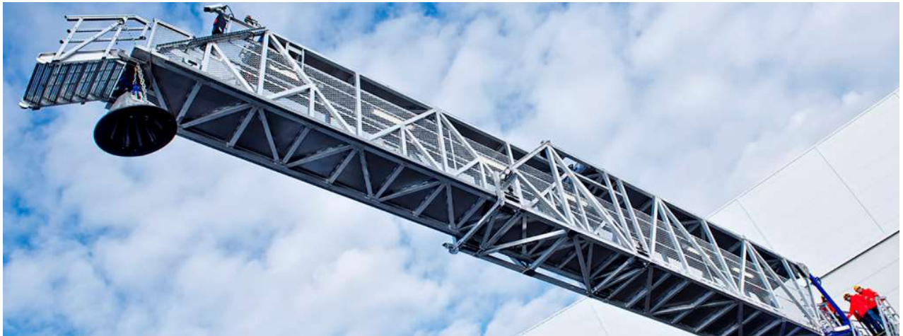
Figur 8-3 Marine Aluminium gangbro under utsetting. Bildet viser også landingskone ved enden av gangbroen. (Bilde brukt etter avtale med Marine Aluminium.)
