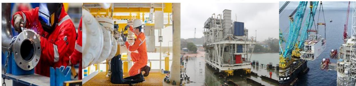
'Stick-building' – bygging på stedet/offshore
