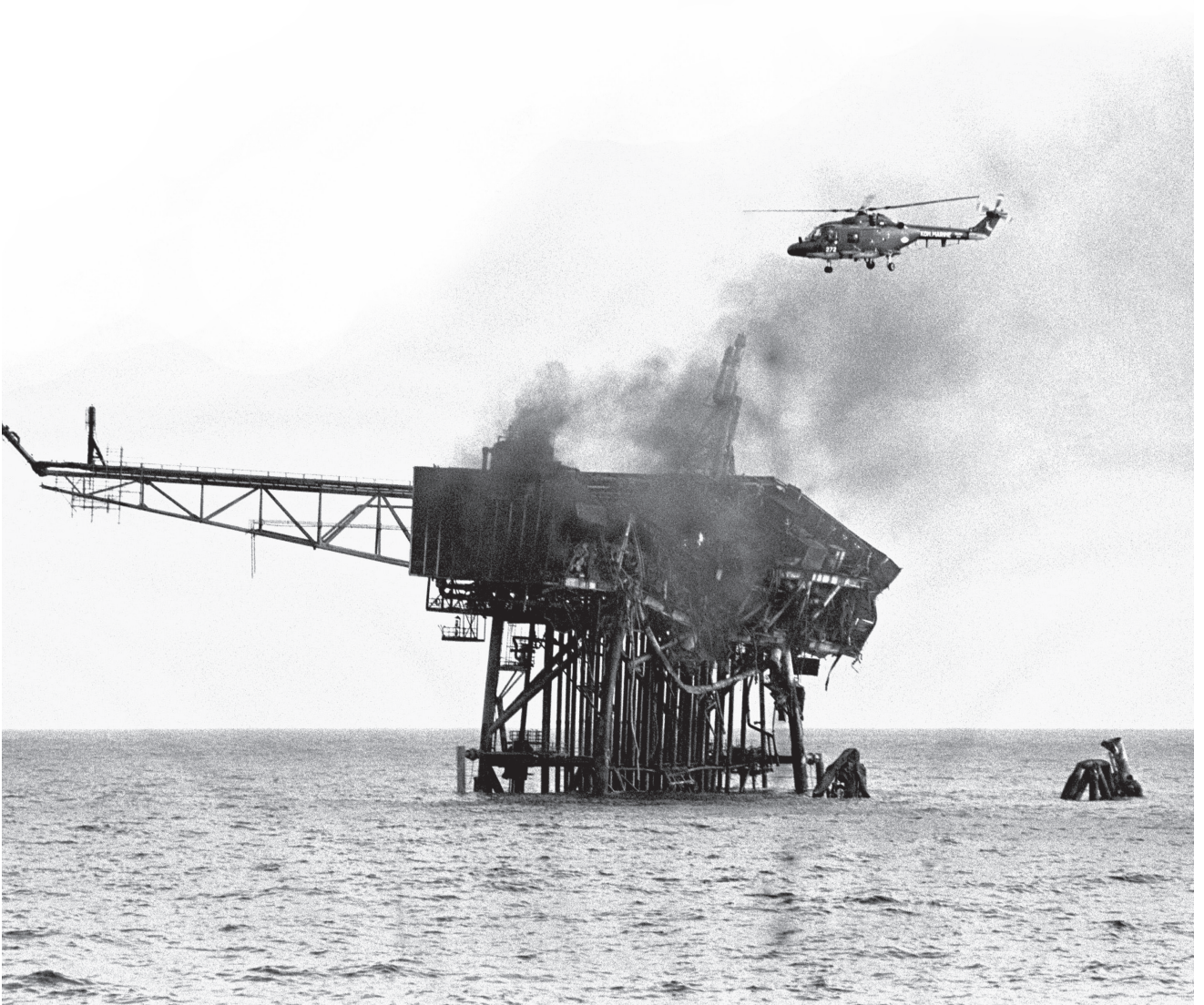
To timer etter den første eksplosjonen, gjekk Piper Alpha i oppløysing. Størsteparten av innretninga sank i havet, inkludert bustadkvarteret. Dette biletet er frå dagen etter ulykka, den 7. juli 1988, og viser dei utbrende restane av plattformen. (Foto: NTBScanpix/PA Photos)
