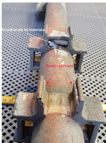
Figur 13. Kilde: Equinor rapport MAT-2023021 Spir som feilet
