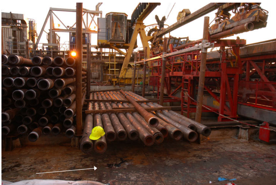
Bilde 2: Bilde fra rørdekk. Kranen er i posisjonen den befant seg i etter at ulykken inntraff og lasten var sikret. Hvit pil viser hvor skadet person befant seg.
