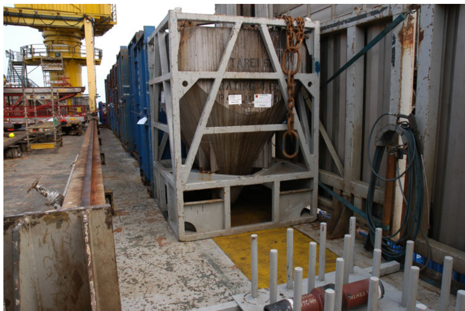
Bilde 5: Bilde viser gulmerket evakueringsvei som er blokkert
