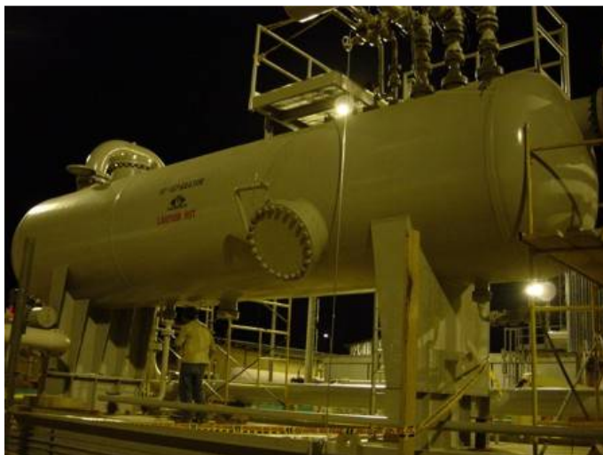
Figur 8-2 En gravitasjonsbasert separator, (ref. /45/)
