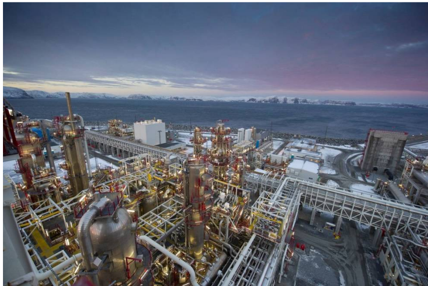
Figur 4-2 LNG-anlegget på Melkøya (Kilde: Statoil/Øyvind Hagen)
