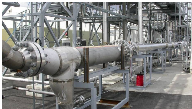
Figur 8-4 Testtrikken til rørseparator under testing på Herøya (ref. /10/)
