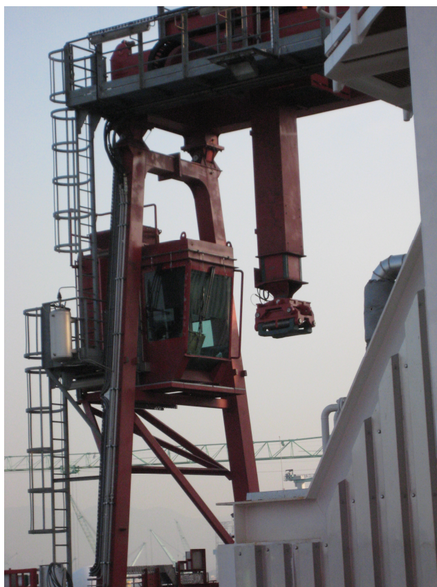
Fig 4 Tilkomst til dekkskraner 5.3.21 (riserhåndterings kranen)
