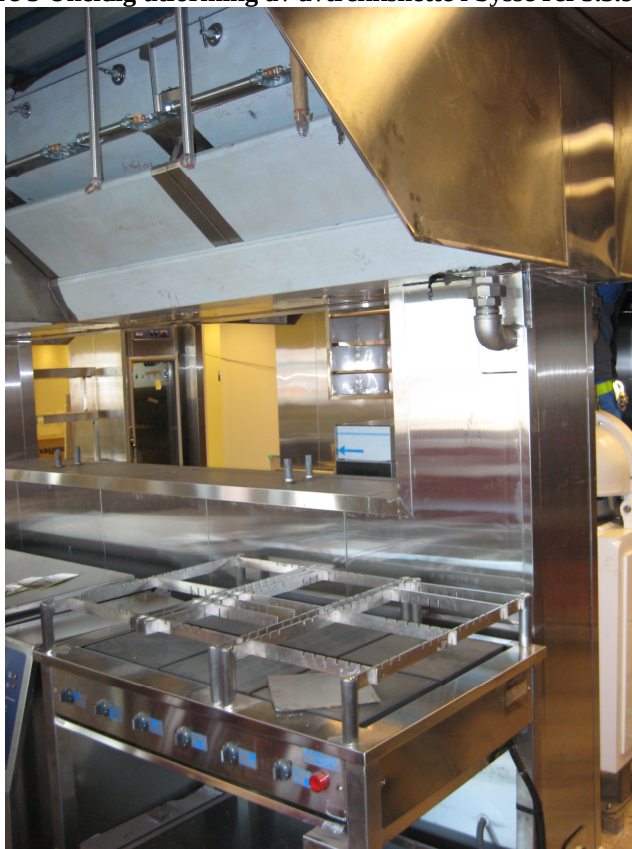
Figure 3 Uheldig utforming av avtrekkshette i bysse ref 5.3.9
