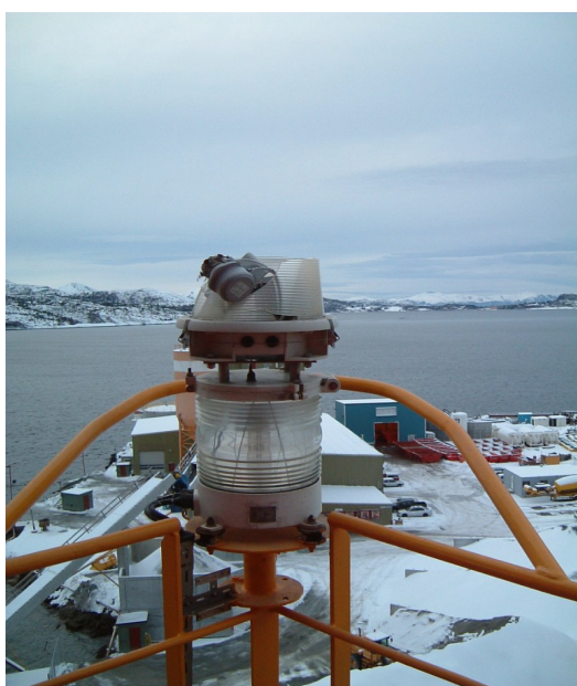
Ødelagt kuppel på signallyset
