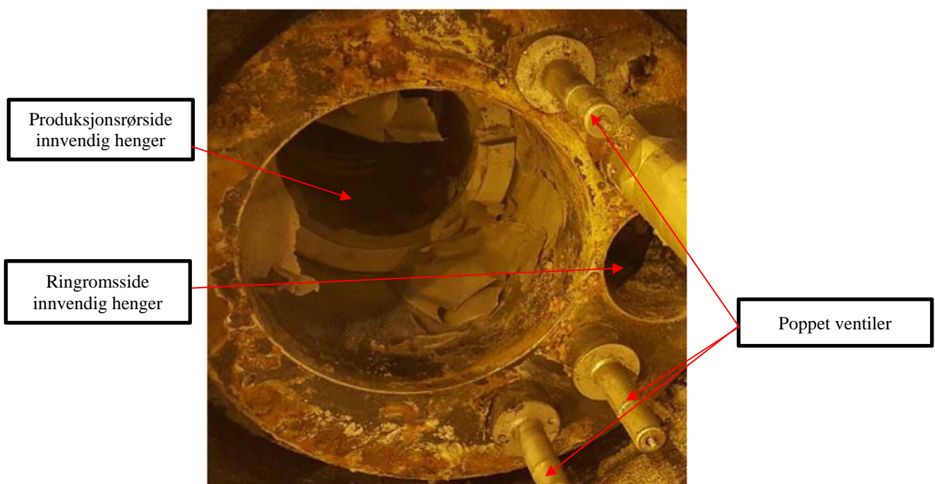
Figur 11 Poppet ventiler innvendig i produksjonsrørhenger (kilde: GE VetcoGray)
