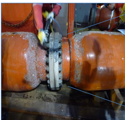
Foto 4.1 Flenskobling mellom slangesegment 2 og 3
