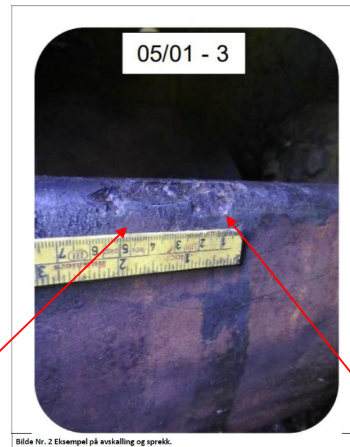
Bilde Nr. 2 Eksempel på avskalling og sprekk.
