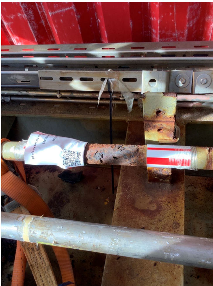
Bilde 5 Lekkasjepunkt 2, UK målestasjon, Statfjord B (Kilde: Bilde tatt under vår gransking)
