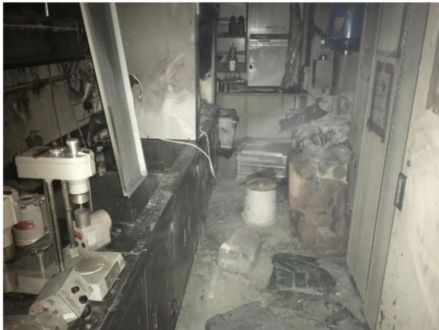
Figur 4 Oversiktsbilde i slamlaboratoriet etter brannen (fra Seadrill)
