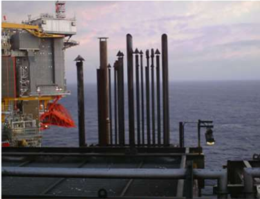
Figur 12 Lysarmatur plassert på vindsiden av avluftingsrørene.
