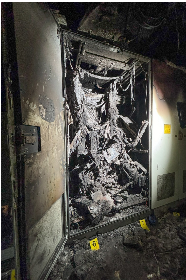
Figur 27 Brannskader vekselretterdel av VSD (Kilde: Politiet)
