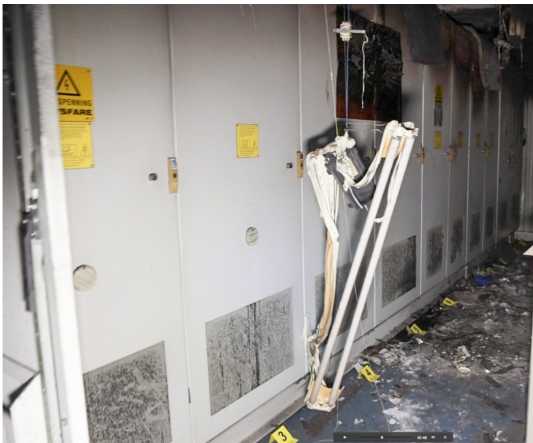
Figur 10 Bilde av VSD etter brannen. Bilde viser skapdør 2 til og med 11. (Kilde: Politiet)
