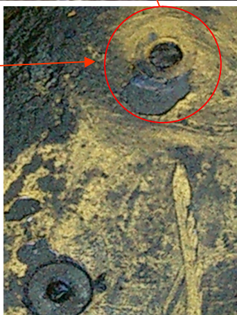
Detaljer på plassering av øyebolt på casing guide
