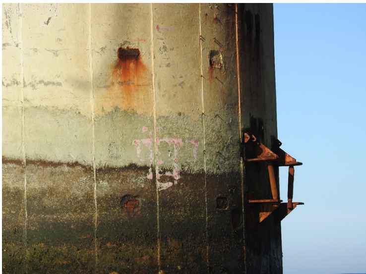
Bilde: Skadested boreskaft sør (kilde: Equinor)
