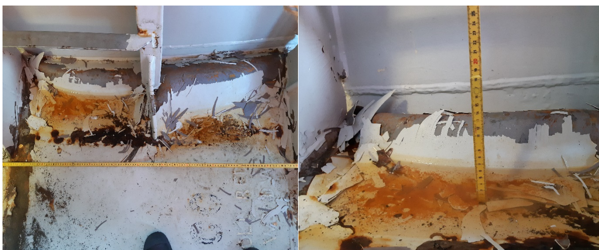
Bilder: Oppbuling av dekkplate
