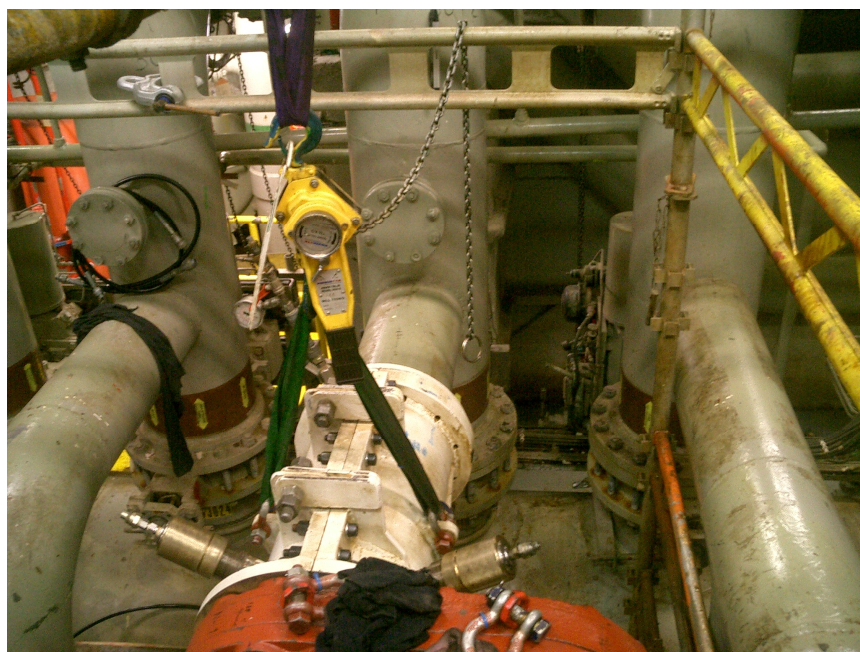
Fig 4.2 - Hot-tap maskin oppkoblet – sagstøttene ses på hver side, manifold og rørføring til cellene ses i bakgrunnen
