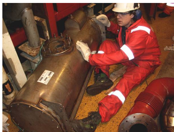
Bilde 4 – Fra rekonstruksjon, eksoskjøleren er vippet tilbake for å frigjøre benet.
