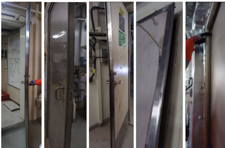
Bilde 10 Eksempler på skader på dører i shakerrommet og tilstøtende områder der dørblad er skjevt/buler (kilde: Havtil)
