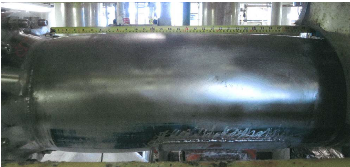
Figur 11 Deformert rørstykke mellom reguleringsventilen HCV 20021 og lekkasjested. (Kilde: Statoils granskingsrapport)
