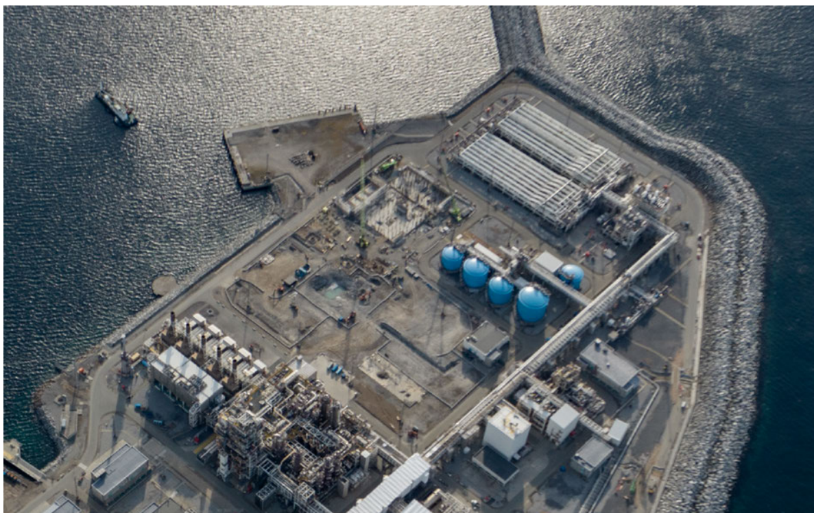
Figur 6: Viser hvordan området L201 og grusplassen så ut 13.08.2024. Bilde er et utsnitt av bilde mottatt i (Equinor, 017).
