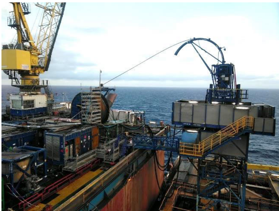
Bilde 3 - Opprigging av kveilerør
