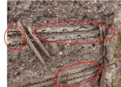
Figur 6-12: Funn 1.17.N0. To bunter med korrodert ringarmering nedskutt, markert med rødt
