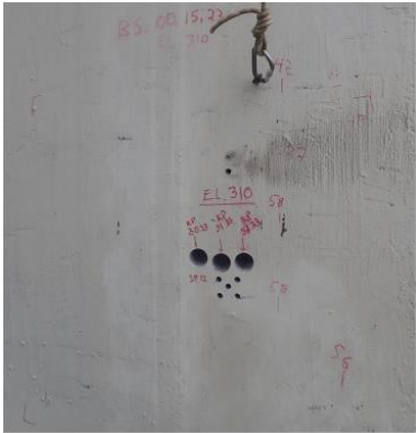
Figur 4-2: Plassering av kjerneprøver/RCT i utstyrskaftet.
