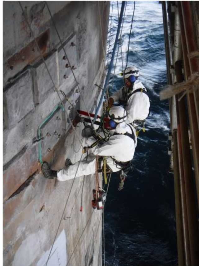
Figur 5-10: Kjerneboring rundt rondellene
