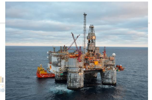
4 søyler 4 pontonger 2 bjelker
