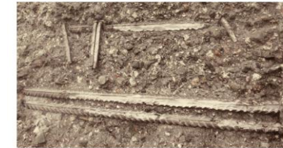
Figur 6-13: Felt med korrosjon på ringarmeringen, funn 1.17.nordøst
