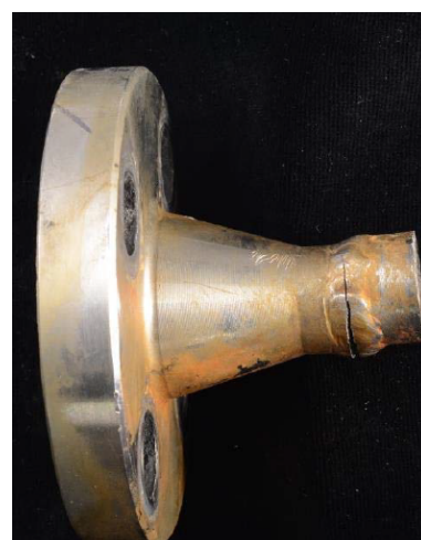
Figur 12 - Bruddflaten sett fra siden i forbindelse med DNV GL undersøkelse. Bilde tilhører Engie E&P.
