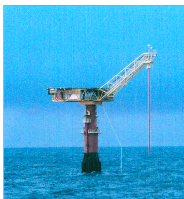
Bilde 4-2: FLP etter brudd i lasteslangen
