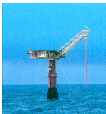
Bilde 4-2: FLP etter brudd i lasteslangen
