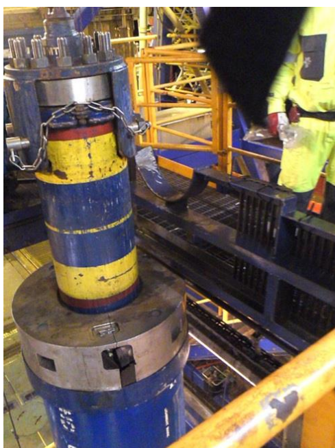
Bilde 14 Tatt etter hendelsen og viser posisjon av strekkstagskompensator i forhold til den aktuelle lukekarmen på BIT BOP dekk der dekkstrukturen løsnet (kilde: Statoil)
