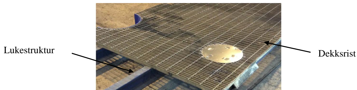
Bilde 4 Dekkrist på lukestruktur (kilde brukermanual)
