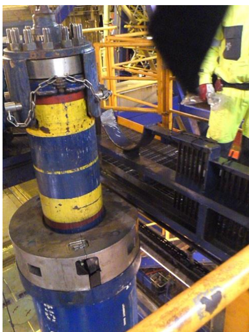
Bilde 14 Tatt etter hendelsen og viser posisjon av strekkstagskompensator i forhold til den aktuelle lukekarmen på BIT BOP dekk der dekkstrukturen løsnet (kilde: Statoil)
