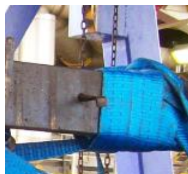
Bilde 9 Deformert dekkrist-feste hvor dekkristen løsnet fra
