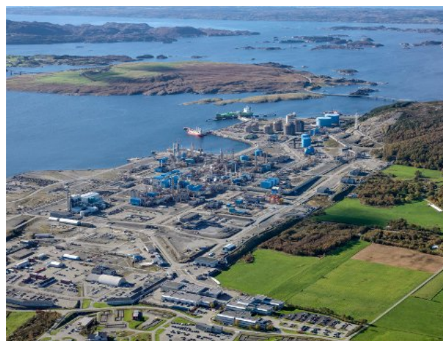
Bilde 2 Kårstø anlegget Kilde: Equinor
