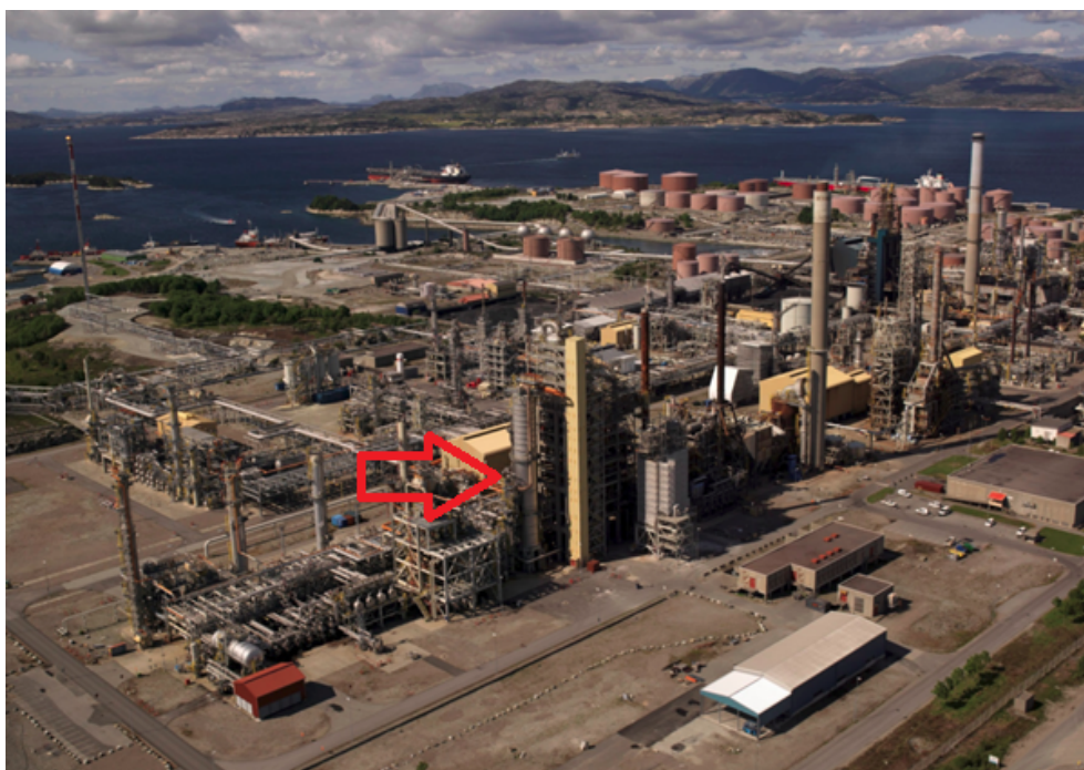
Figur 2: Oversiktsbilde av Statoil Mongstad. R d pil viser krakkeranlegget.
