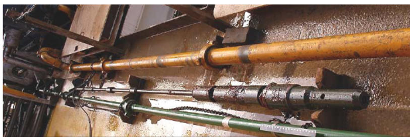
Bilde 4: Uttrekkerverktøyet og pluggen som ble lagt ned på toppdekket
