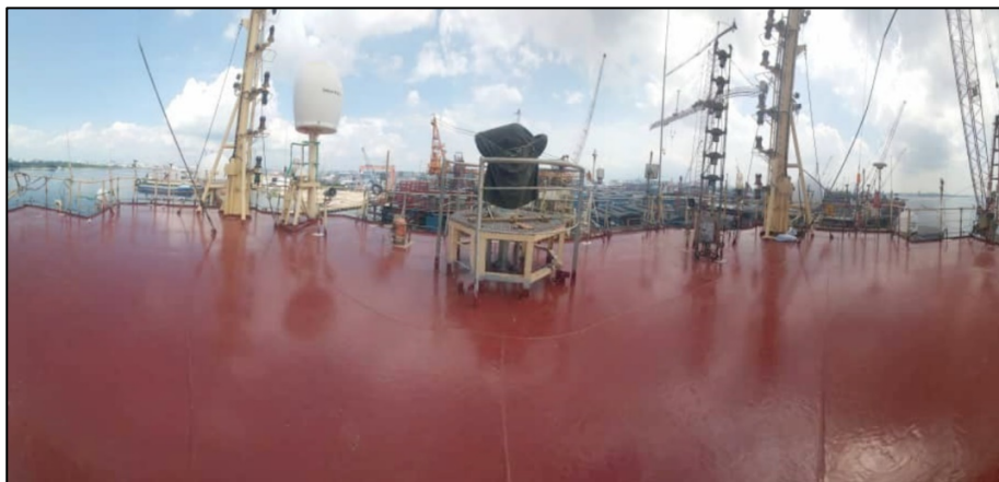
Figur 5-38 Gjenoppbygging av dekk på en FPSO (Kilde: SPS Technology).
