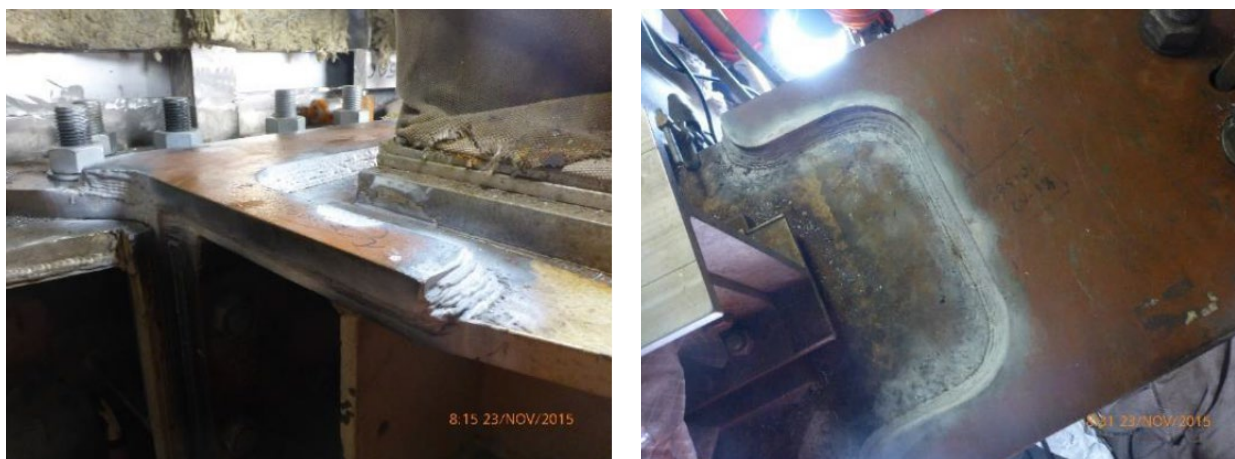
Figur 5-21 Eksempel på lokal forsterkning av innfestingen av helikopterdekk
