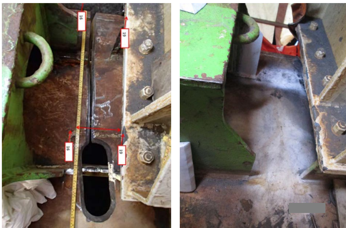
Figur 5-1 Eksempel på sveisereparasjon av dekkplate på en FPSO
