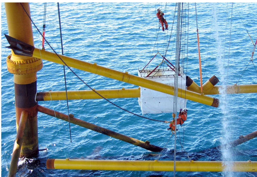
Figur 5-27 Nye diagonalstag for en fagverkskonstruksjon installert ved hjelp av tilkomstteknikk basert på tau (Kilde: Linjebygg)
