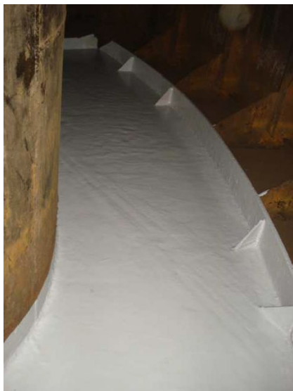
Figur 5-34 Reparasjon i bunnen av en ballasttank, etter maling (Kilde: D. McGeorge, DNV GL)
