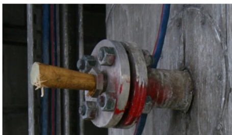
Bilde nr 5. Lekkasjepunktet med treplugg
