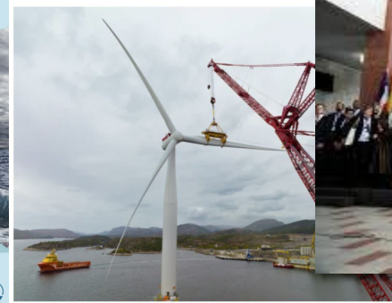
Montering av flytende vindmølle til prosjektet Hywind Tampen i Gulen i Vestland fylke, mai 2022. (Foto: Jan Arne Wold/Equinor)
