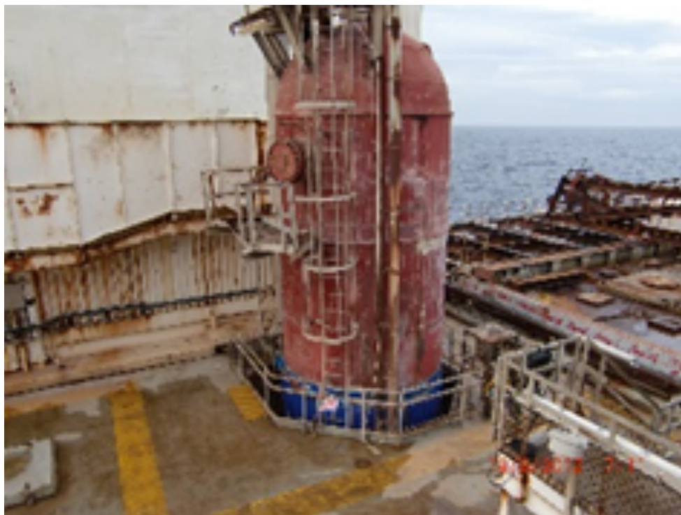
Passiv brannbeskyttelse innholdende asbest er fjernet.
