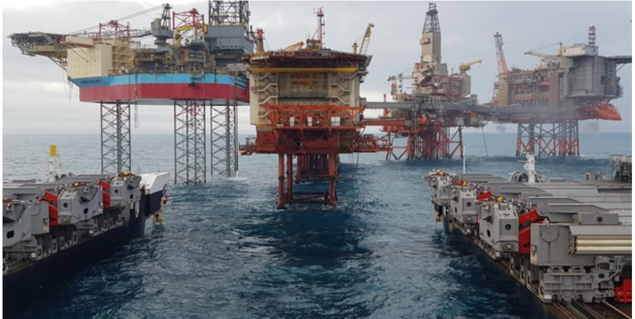
Bilde 13-1 Ettløftfjerning posisjonering av PS
