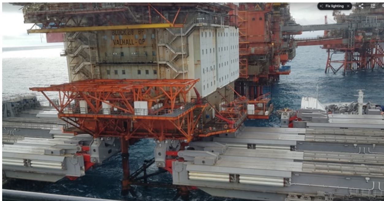
Bilde 13-2 Ettløftfjerning - løftearmer plassert under overbygningen
