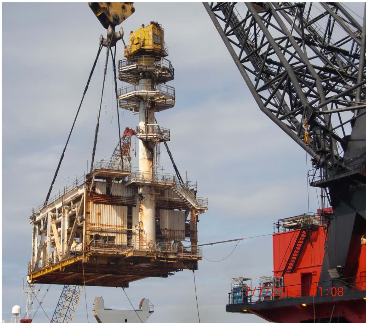
Bilde 12-1 Modul fjernes med tungløftmetoden - reversert installasjon
