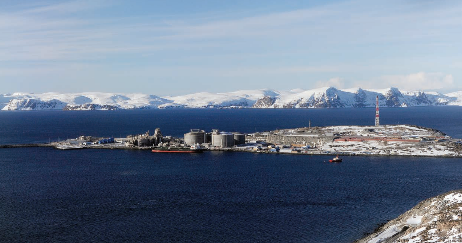
Figur 5.3 Melkøya landanlegg. (Foto: Harald Pettersen, Equinor)
