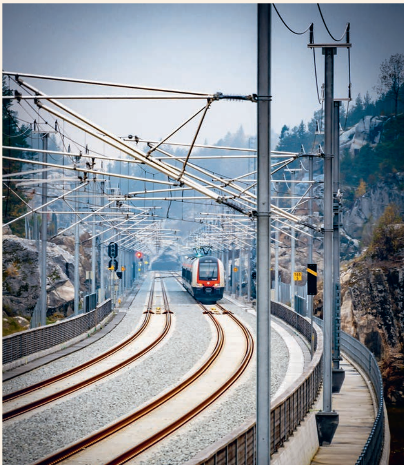
Figur 3.4 Elektrisk tog. (Foto: Bane NOR)
