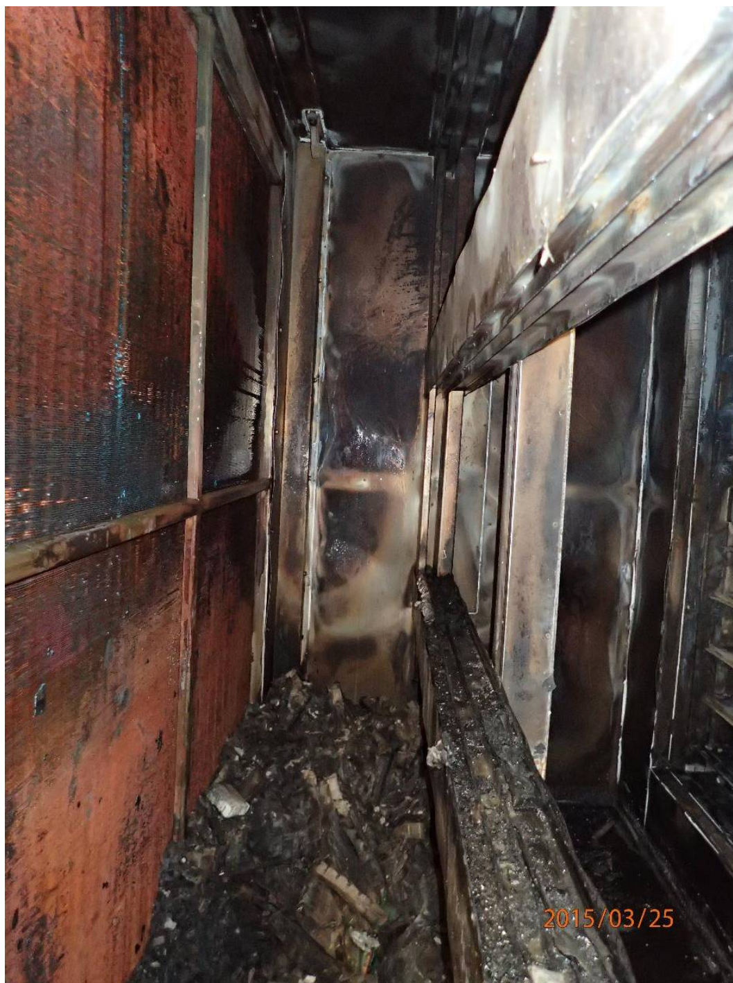
Figur 4 - Utbrente filterkassetter i AHU-A (Kilde: Ptil gransking)
