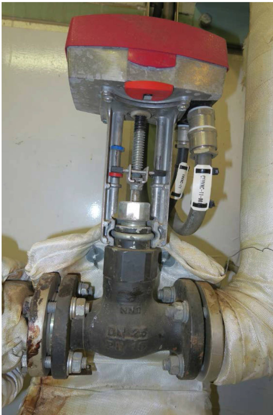
Figur 2 Dampventil type TAC modell nummer VGS211F-25-10 med aktuator av typen Schneider M800 (kilde: TKPJ).
