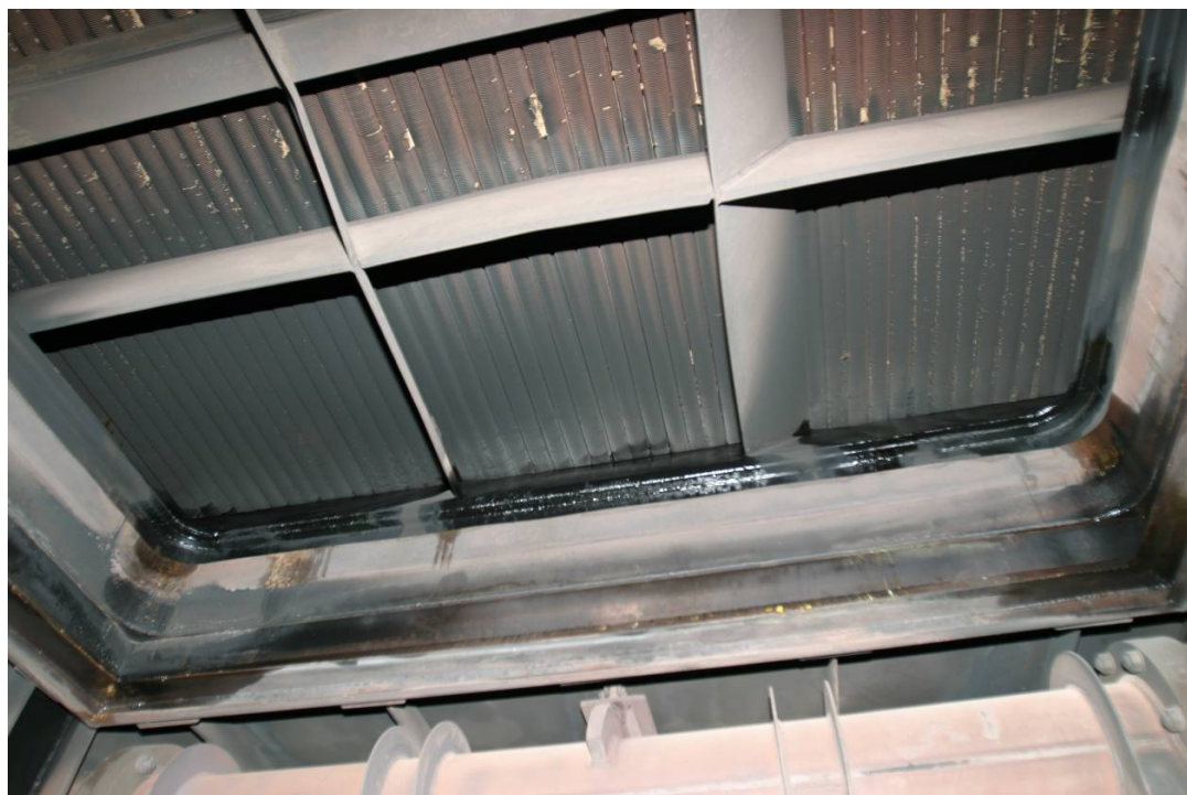
Figur 6 Varmeveksler sett nedenfra
