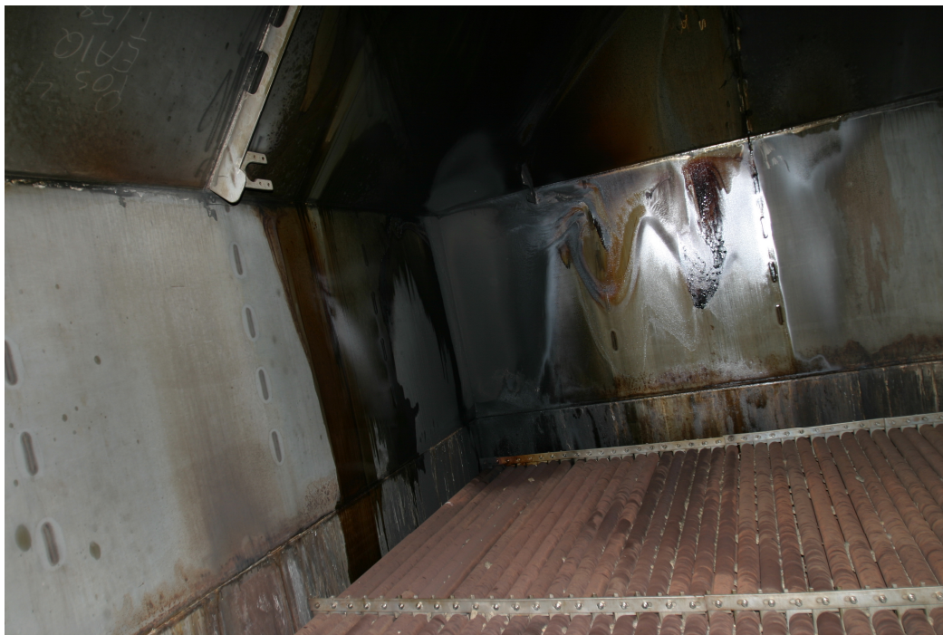
Figur 7 Varmeveksler sett fra toppen
