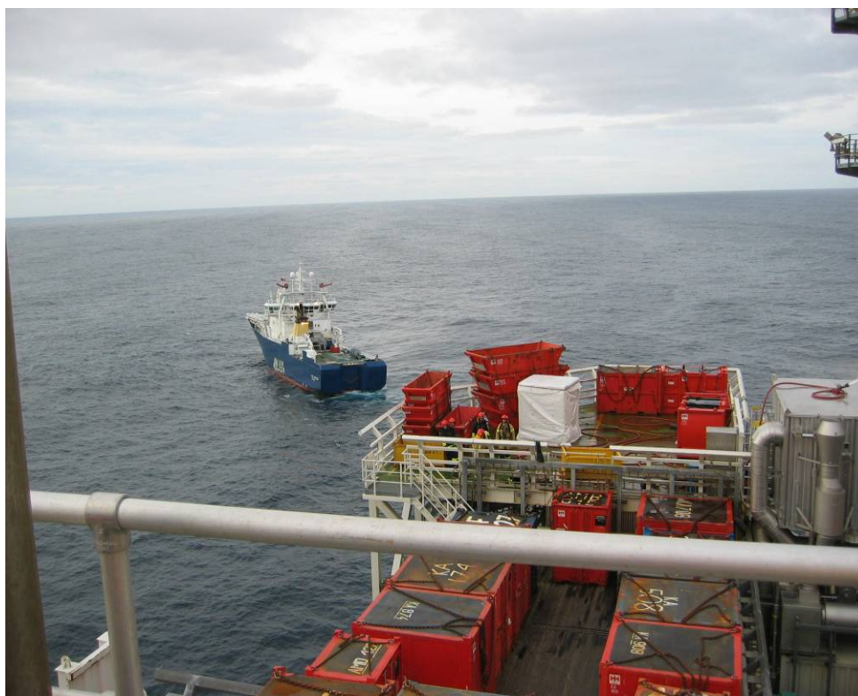
Figur 3 Bærbar brannkanon på kontainer v/kran nord
