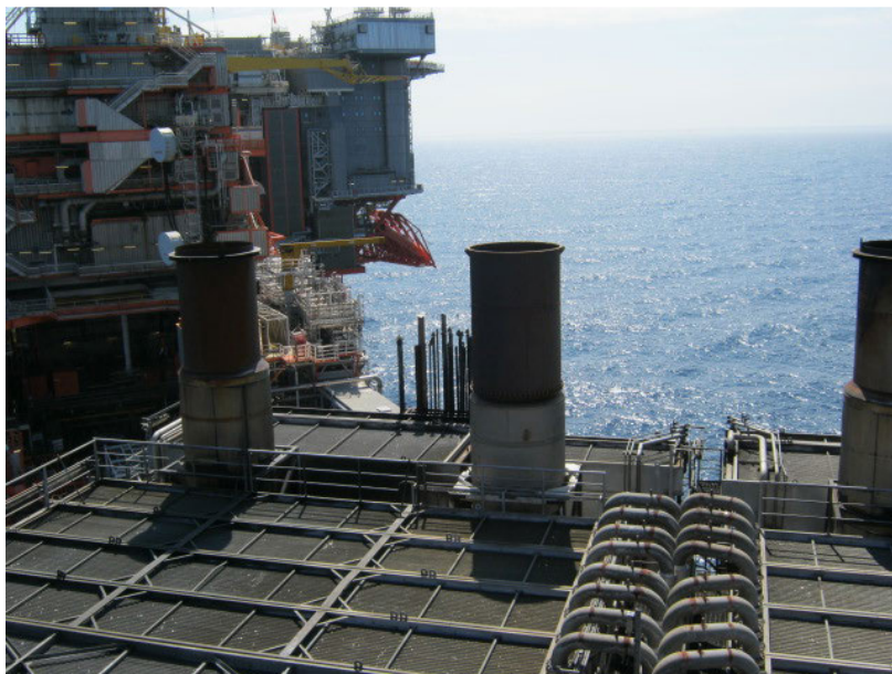
Figur 13 Turbineksosen er plassert på vindsiden av avlufts-rørene. Bildet er tatt fra PCP-kranen.
