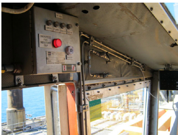
Figur 11 Brann- og gasspanel for lokal varslings av kranfører er plassert bak kranfører og over døren. Lydsignalet er satt ut av funksjon.
