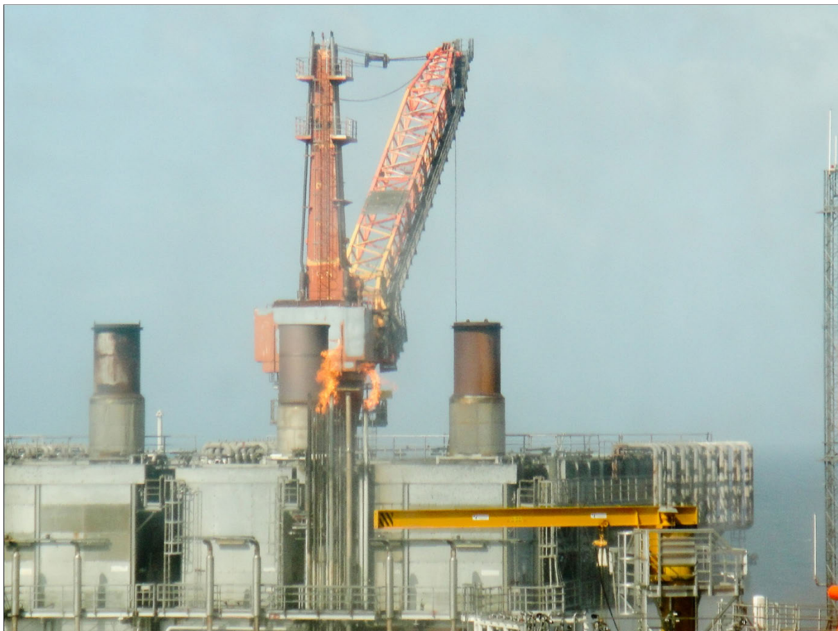
Figur 3 Brannen i avluftingsrørene sett fra PH-innretningen kl. 17.10
