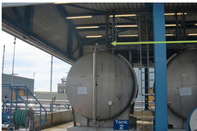
Stedet hvor arbeidet skal foregå
