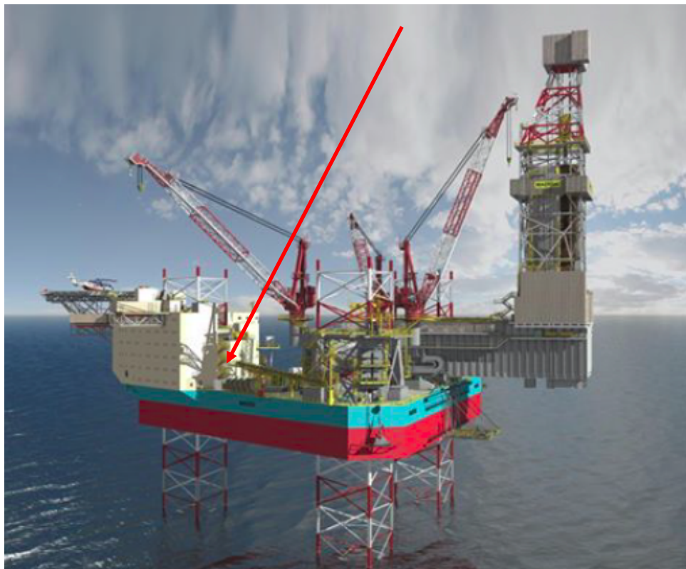
Bilde 4: Pilen viser hvor råvannspumpen skulle installeres
