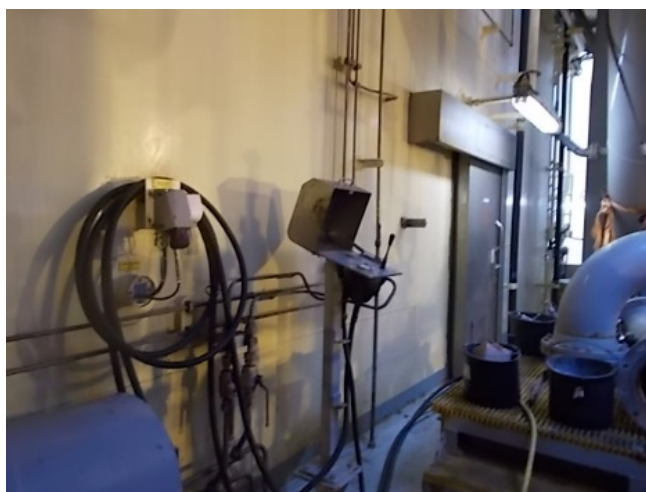
Bilde 12: Operasjonspanelet og styreventilene for å operere avlastningsoppheeng for råvannspumpen
