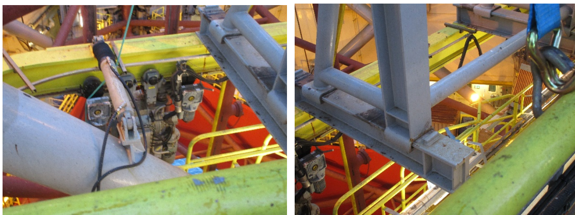
Bilde 10: Innfesting av kranbane med justeringssylindere for inn- og utjustering av kranbanen
