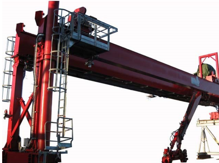
Figur 8-5 Horisontal rørhåndtering, traverskran borerørslager
