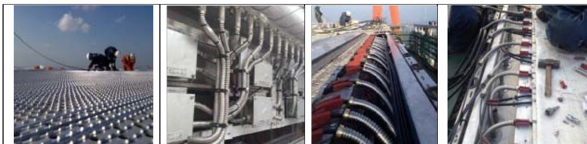
Figur 10-6 Heat tracing av helidekk på ENIs Goliat plattform (ref. http://www.traceteam.no/referenceitem/eni-goliat-fpso-helideck-area )
