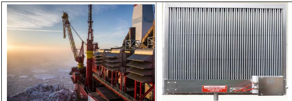
Figur 9-6 Løsninger for å hindre snø/isoppbygging på luftinntaket til hovedgeneratorer (venstre: Luftinntak til generatorer på Pirazlomnaya plattform (ref. Gasprom netside), høyre: vinterisering av luftinntak vha. varmekabler fra Veotec)
