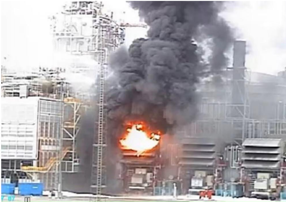
Brann i luftinntaket på gassturbin Hammerfestanlegget 28.9.2020 Foto: Equinor
