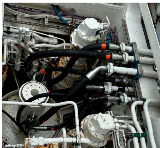
Bilde 6: Svivel med midlertidige hydraulikkslanger (Kilde: Equinor/Island Offshore)
