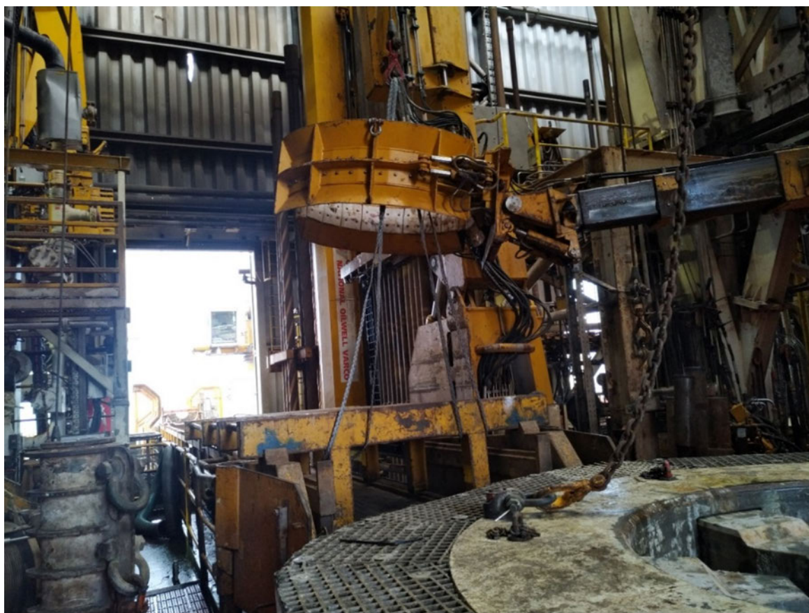
Figur 9 Lasteramme stropet opp med stålstropper til vinsj og justert vha. DFMA
