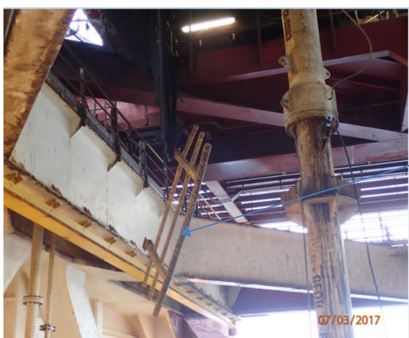
Figur 13 Rekkverket ble knekt av og kastet mot BOP-dekket, der det landet i sikkerhetsnettet.
