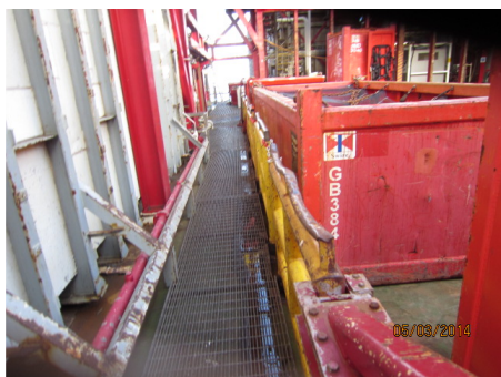
Bilde 9 og 10 – Defekt rekkverk på M22 dekket og rekkverk på helifuel plattform
