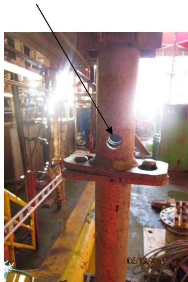
Bilde 6- Stillas uten sikringsbolt
