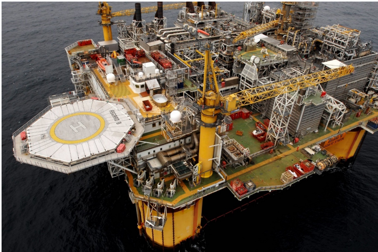
Figur 5: Utsnitt av Åsgard B innretningen, hendelsen skjedde i traforom U54A i hjelpesystem område på nedre dekk: kilde Equinor
