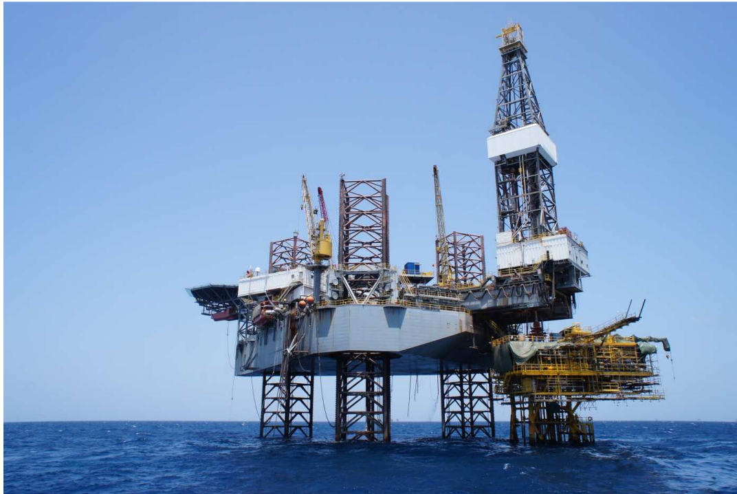
Figur 5-2 Oppjekkbar borerigg over brønnhodeplattform
